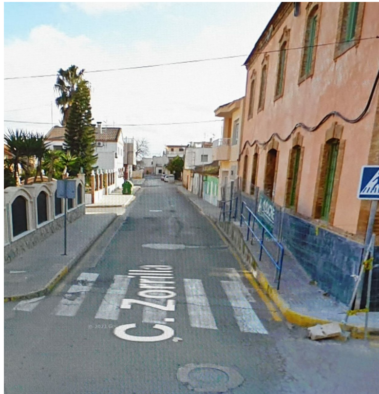
Necesidad de rebaje en paso de peatones sin ejecutar en El Algar
