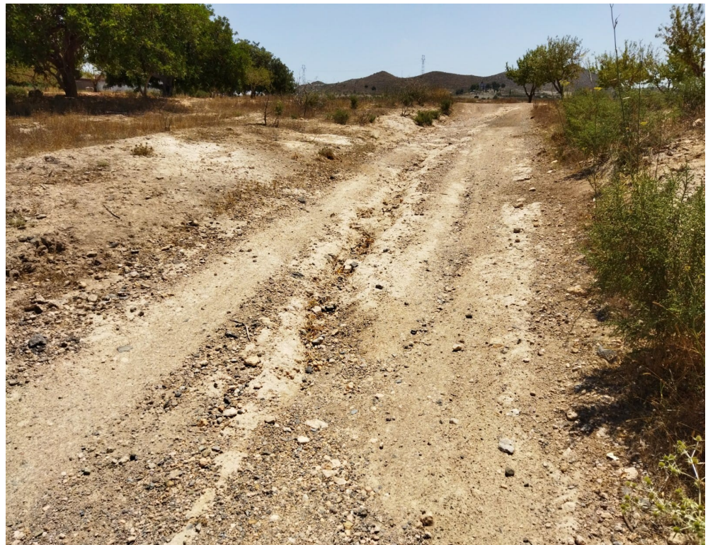
Estado de la vereda tras episodios de lluvias
