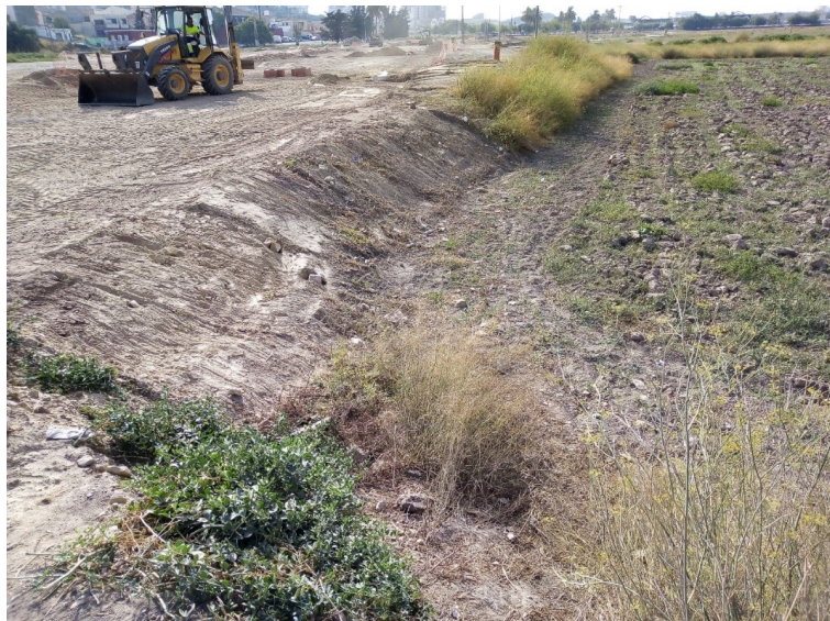
Imágenes de antes y después de las obras, en la intrusión denunciada por los vecinos afectados
