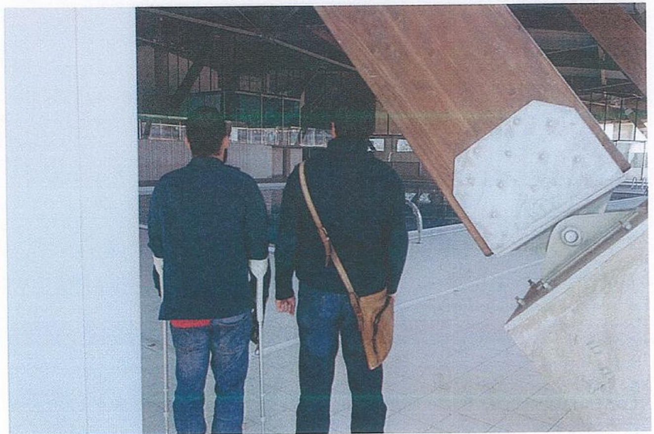
ESPACIO SALIDA EVACUACIÓN ACCIDENTADOS A ENFERMERÍA MUY PELIGROSO
