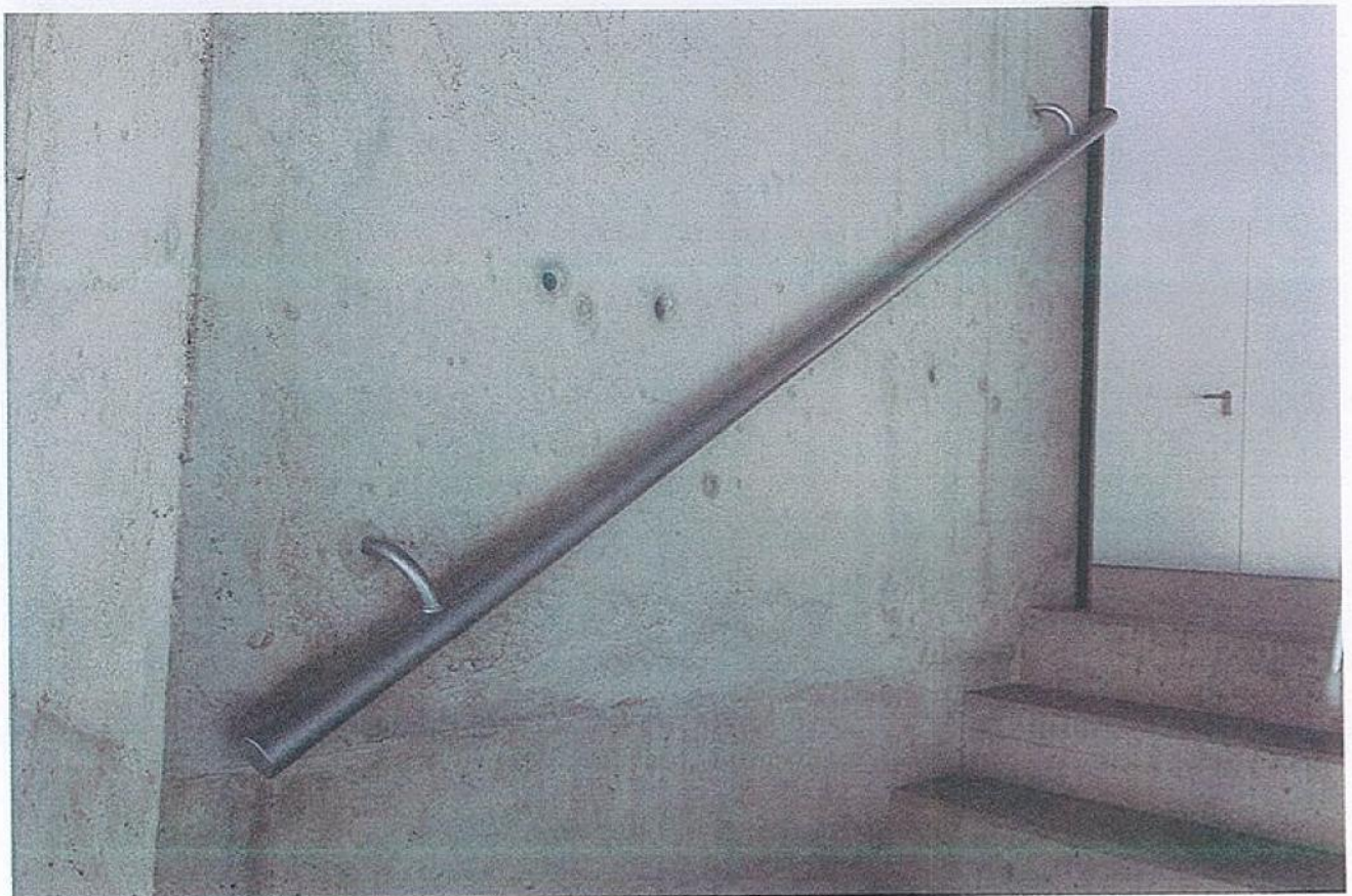
COLOCACIÓN DE LOS TRAMOS DE PASAMANOS EN LAS DISTINTAS ESCALERAS DE LA INSTALACIÓN.
