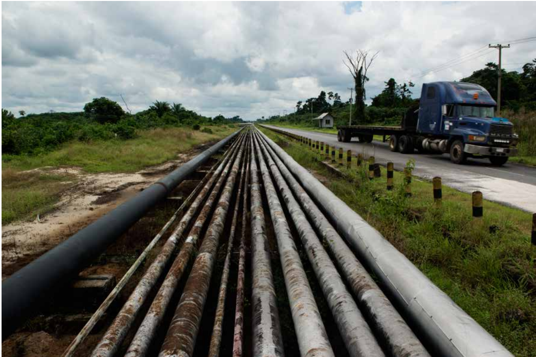
Tuberías para el transporte de fuel. Jala Community. Nigeria 2016.
