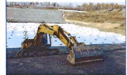
Instalación de un geotextil en una actuación de restauración de suelos.
