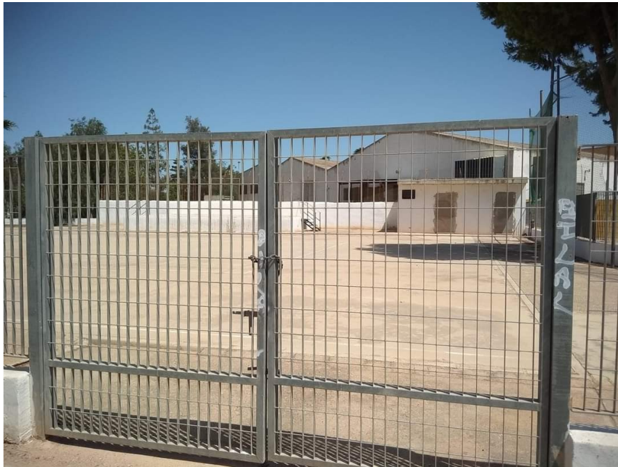
Pista deportiva en desuso
