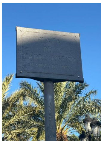
Placa y fuste deteriorados en La Palma
