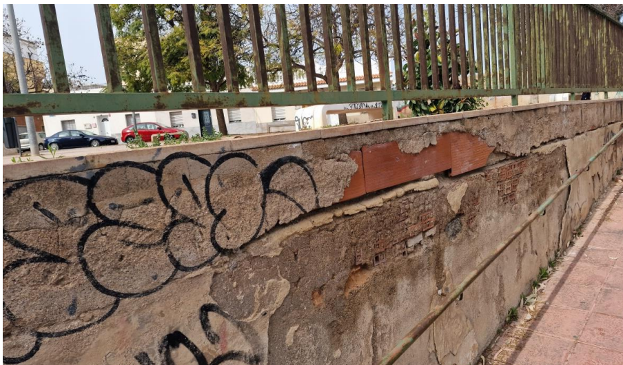
ACCESO PLAZA CALLE JURA SANTA GADEA
