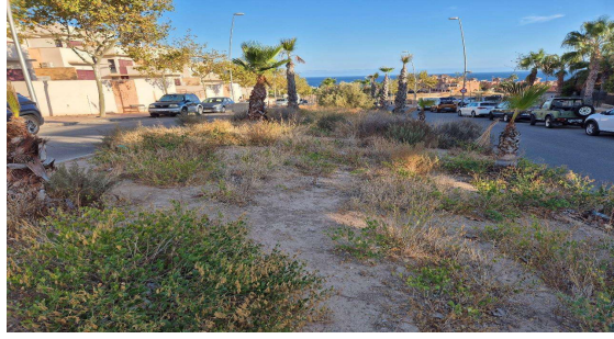
Fotografía correspondiente al estado de la mediana en la Calle Isla del Cangrejo, que ha quedado fuera de contrato de limpieza a día 20 de septiembre de 2025.
